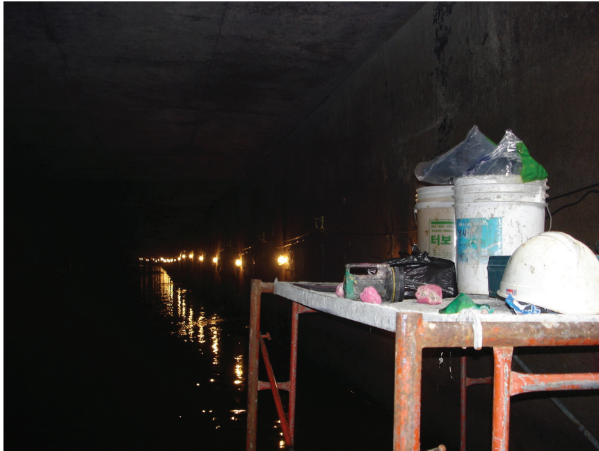
구조물 내 현장전경( 사고당시 작업발판등은 해체완료되었음) (보수보강작업시 조명시설, 작업발판이 주작업 장비임)
